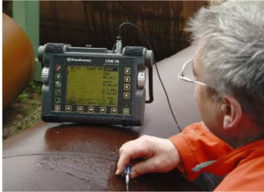
对焊缝进行检测
