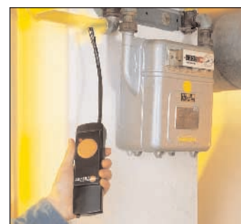
测量煤气管道泄漏状况
